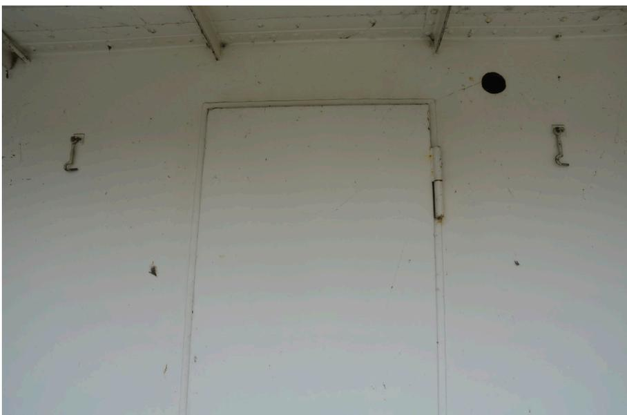
Stahltür, vermutlich jüngeren Datums, mit aufgeschweißten Bändern und originalen Feststellhaken aus Aluminium von 1938.
