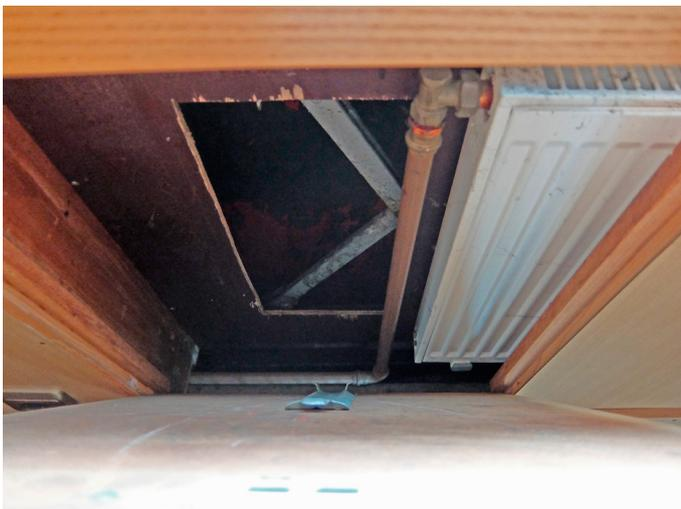
3 neuzeitlicher Heizkörper und bauzeitliche Hebe-mechanik des vertikalen Schiebefensters
